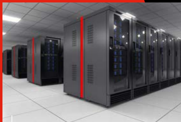
Salles de serveurs
