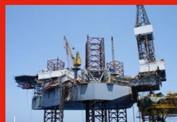
Plateformes de forage
