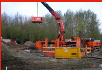
Travaux de construction
